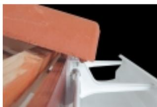
В случае, когда край кровельного покрытия не достаточно выступает над водосточным желобом, есть риск попадания дождевой и талой воды между водосточным желобом и карнизной доской.
