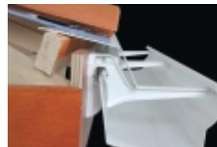
Гидроизоляционная пленка укладывается поверх капельника, Пленка крепится к капельнике скобами или гвоздями.
