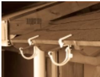
При установке кронштейнов желоба системы 16 применяются кровельные держатели кронштейнов. Конструкция элементов предполагает их использование на кровельных покрытиях различной толщины.
