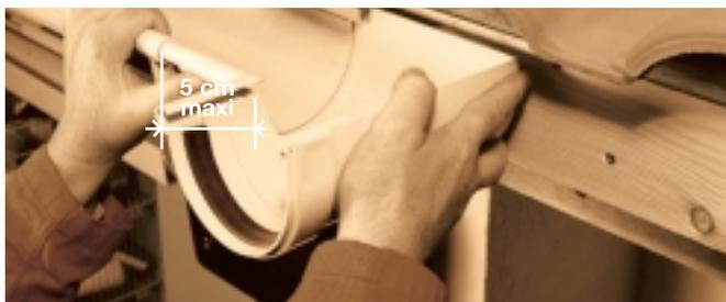
При установке углов на резиновых уплотнителях ближайшие к углу кронштейны желоба должны располагаться не ближе, чем на расстоянии 5 см от края угла.
