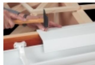
Капельник крепится на краю карнизного свеса кровли после установки водосточных желобов. Шаг гвоздей не должен превышать 0,5 м. Край капельника должен заходить в водосточный желоб не менее чем на 15 мм. После установки капельника укладывается гидроизоляционная пленка (поверх капельника).
